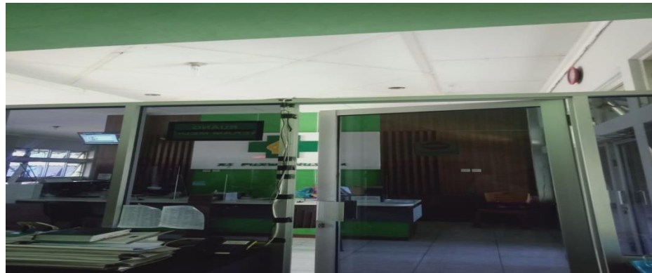
Gambar 4.6 Pintu ruang filig
