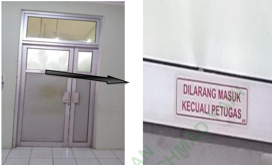
Gambar 4. 13 Pintu ruang penyimpanan BRM
