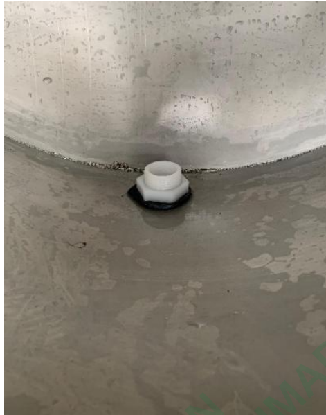
Gambar 4. 19 Lubang Saluran Pembuangan Pada Bak Celup
